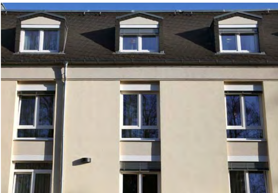
Neue Außenhülle: Dach und Fassade mit noch mehr Bewohnerschutz vor Witterungseinflüssen
